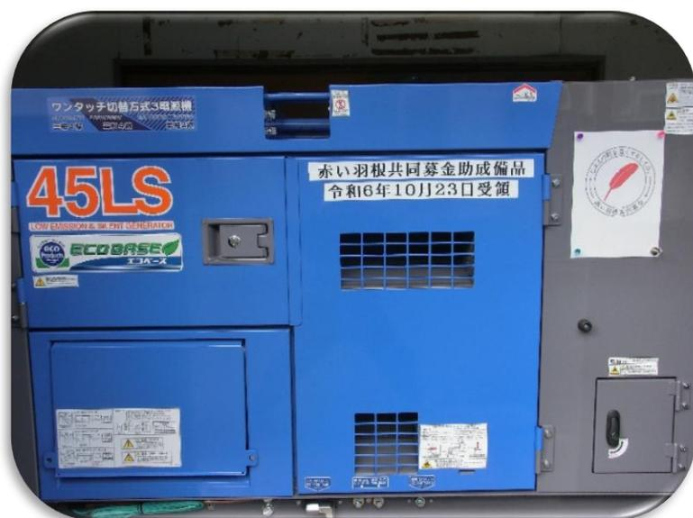
これまで設置していた自家発電装置は、利用者が使用するベッドや人工呼吸器、最小限の照明と通信機器に対応するものでありましたが、今回の赤い羽根共同募金の助成により発電機を増設し、冷暖房設備や、厨房機器へ電力を供給することができ、非常時(災害時)の利用者への支援体制を強化することができました。
